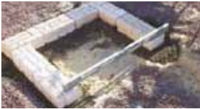
Positionnez le premier rang et vérifiez le niveau.
