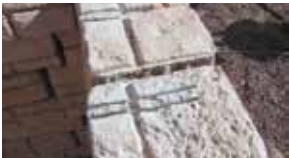
Avec une disqueuse, faites les entailles (11 cm de long).
