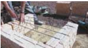
Pré-positionnez les 4 tiges.
