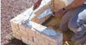
Utilisez un mortier colle de classe C2S1E afin de sceller les blocs entre eux.
