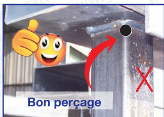
Photos 21 et 22 : Exemple de perçage près d'un angle
