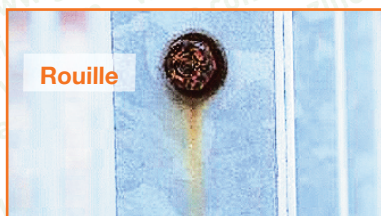
Photo 46 : Boulon électrozingué sur pièce galvanisée, en extérieur
