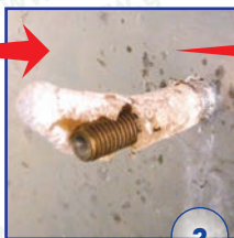
Photos 41, 42 et 43 : Protection par un capuchon de silicone THT
