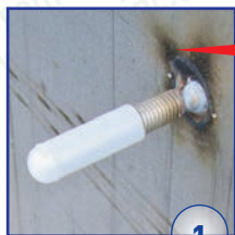
Photos 41, 42 et 43 : Protection par un capuchon de silicone THT
