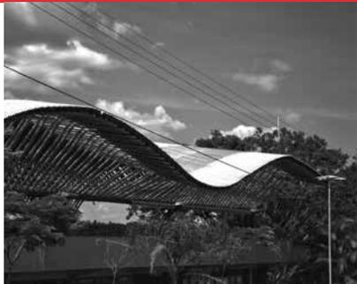
Les plaques ONDUCLAIR® PC sont constituées de résine polycarbonate (résine thermoplastique). Les plaques ONDUCLAIR® PC sont destinées à la réalisation de couvertures et bardages (droits ou cintrés), translucides ou opaques de tous types de bâtiments (habitations, locaux tertiaires, industriels ou agricoles).
